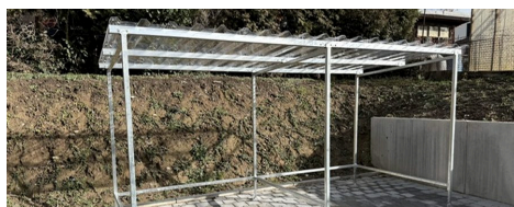
Aménagements extérieurs Poteaux de parking, vélos, conteneurs
